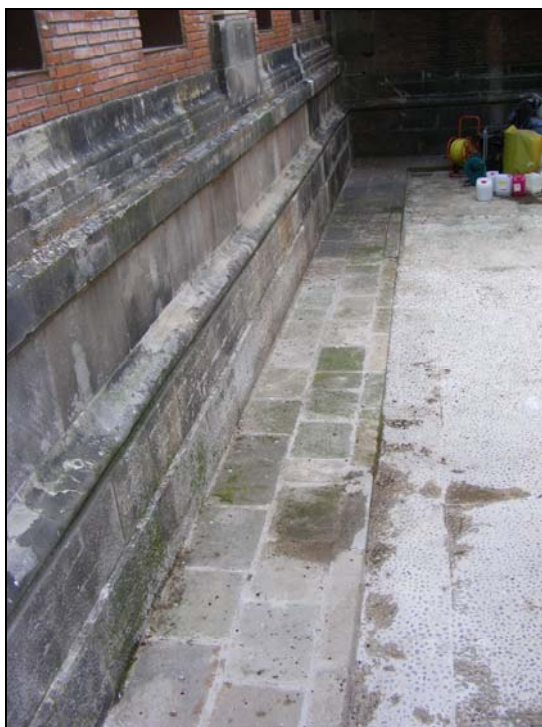
Fig. 30.- Vista general del paviment abans de l'inici de la intervenció.
