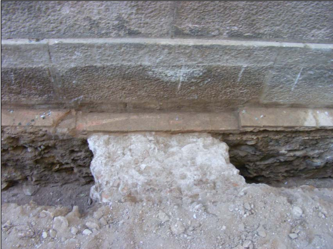
Fig. 32.- Vista de la fonamentació U.E. 504.
