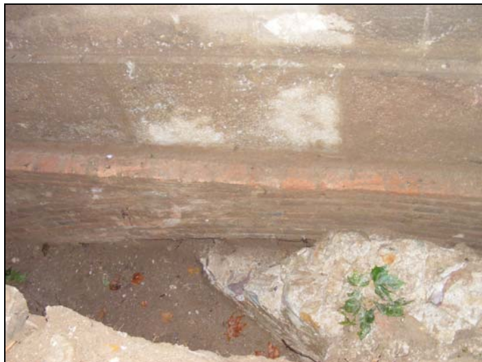
Fig. 24.- Vista del mur U.E. 117 encavalcat per un d'aquests arcs de descarrega, U.E. 133, entre pilars.
