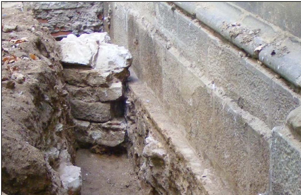
Fig. 21.- Vista del mur U.E. 125 i la seva fonamentació U.E. 126.
