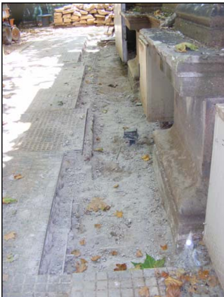
Fig. 33.- Vista general un cop extret el paviment U.E. 201.
