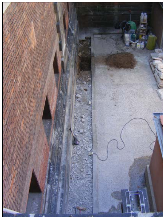
Fig. 31.- Vista general del pati nord est un cop extret el paviment.
