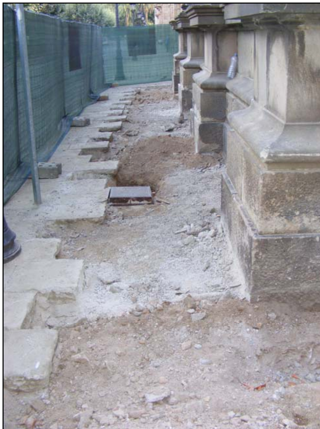
Fig. 37.- Vista general de la façana oest sense el paviment.
