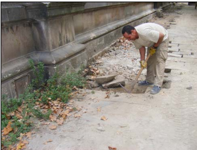
Fig. 17.- Procés d'extracció del paviment.
